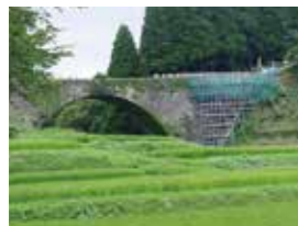
通潤橋 (2019年10月撮影)
