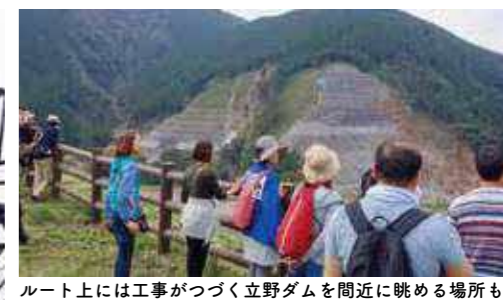
ルート上には工事がつづく立野ダムを間近に眺める場所も
