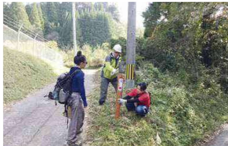
フットパスルートの要所要所に看板を設置する作業
