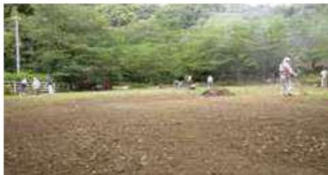
ふれあい広場の整備作業風景
