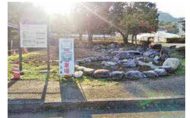
[工事後の石橋公園]
