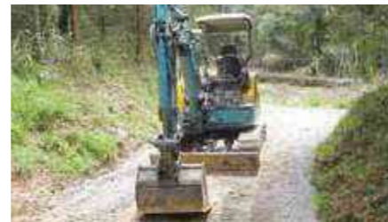
重機をつかって登山道の整備
