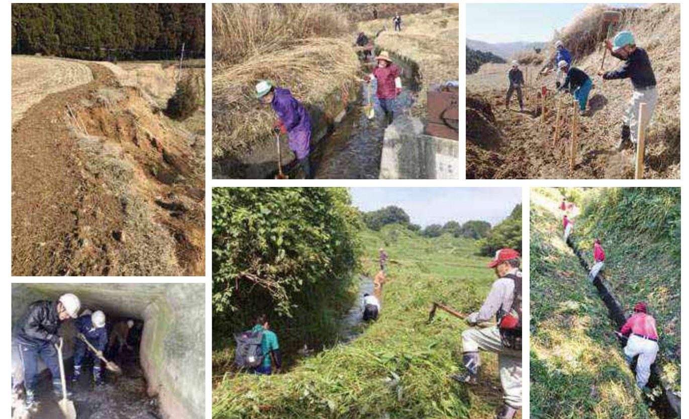
熊本地震で崩落した棚田の法面や、土砂で埋まった用水路など、住民らで整備。年に数回の土砂上げや草刈りには、地元の学生たちも参加する
