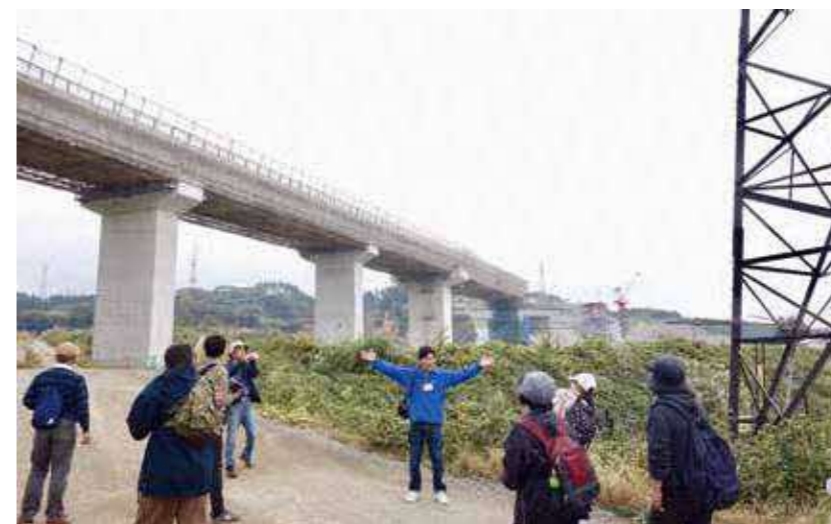
新たな阿蘇大橋の架橋や、集落の復興状況を現地で体感。これが、立野式の復興フットパス
