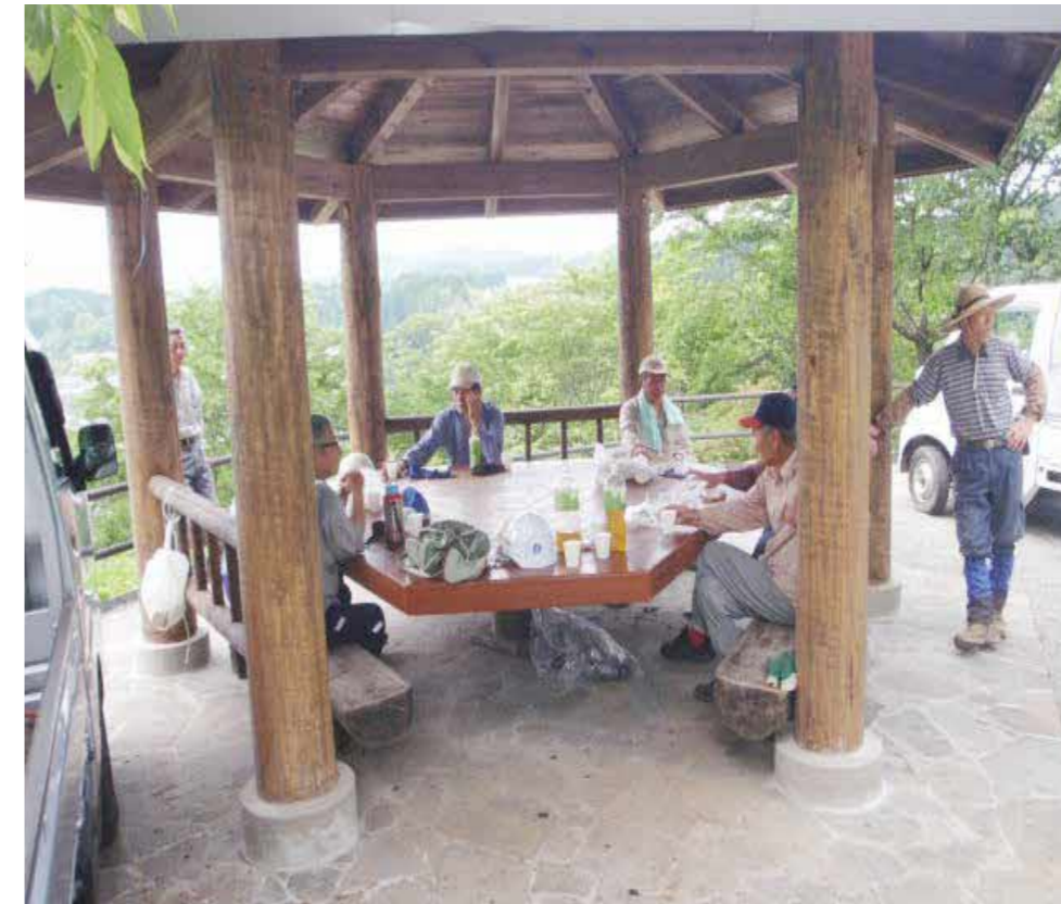
老朽化していた東屋を、里モンの助成で修復・整備。作業中や散策客の憩いのスポットに
