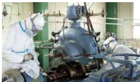
石綿が使用された機場における維持管理作業
