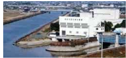
湛水防除事業により整備された排水機場
