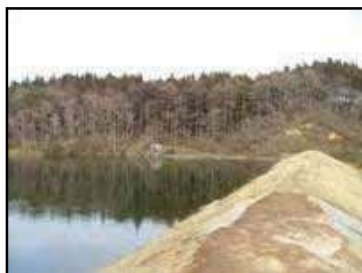
改修前のため池
