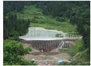
地すべり対策工事の完了
