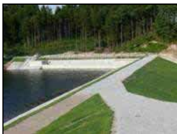
改修後のため池
