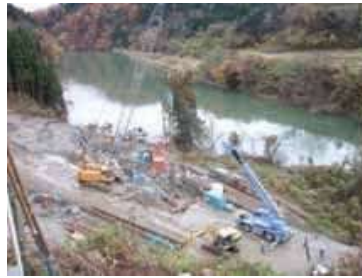
地すべり対策工事の実施
