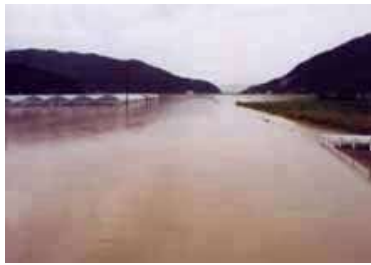
溢水した排水路
