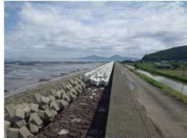
消波ブロック整備状況
