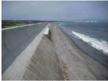
堤防整備状況
