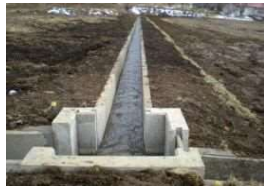
コンクリート水路への更新
