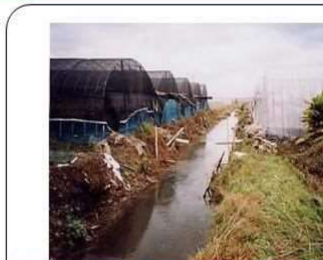
(事業実施前) 排水路の排水能力が低く、常に地下水位が高い状態で、収量・品質の低下が懸念される。
