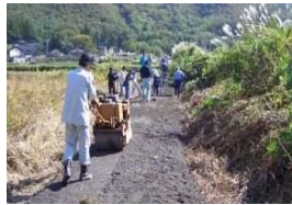
農道のアスファルト舗装
