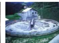
畜産環境対策施設
