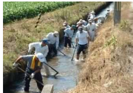
水路の泥上げ
