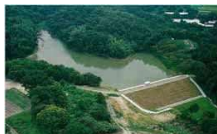
整備されたため池の全景
