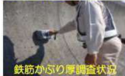
鉄筋かぶり厚調査状況
