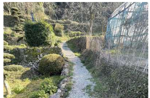
水源までの通路整備
