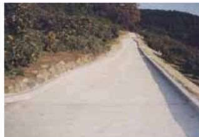
農地保全整備事業により整備された水兼農道
