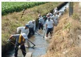
水路の泥上げ
