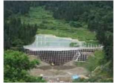
地すべり対策工事の完了
