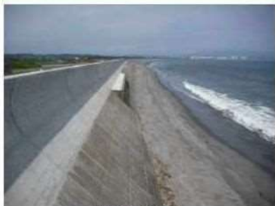
堤防整備状況
