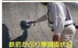
鉄筋かぶり厚調査状況
