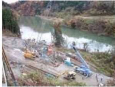
地すべり対策工事の実施
