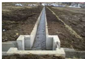
コンクリート水路への更新
