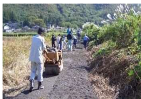
農道のアスファルト舗装
