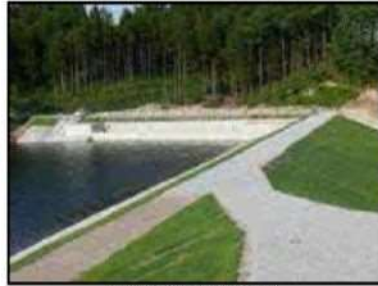
改修後のため池
