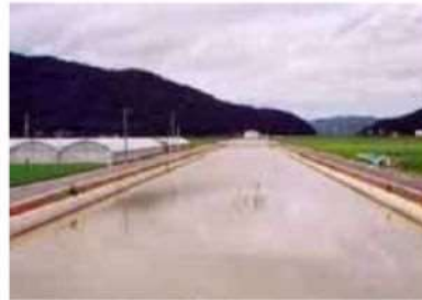
湛水防除事業により整備された排水路
