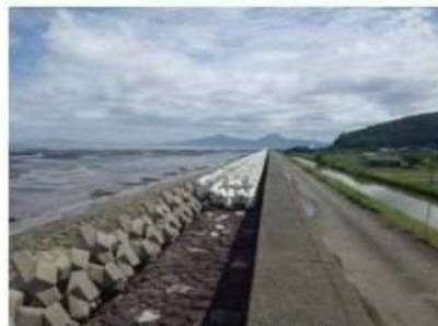
消波ブロック整備状況
