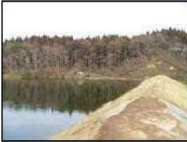
改修前のため池
