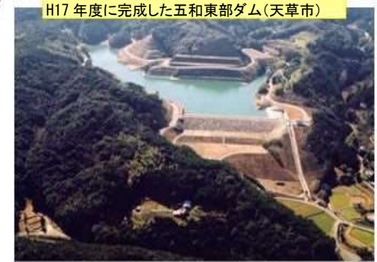
H17年度に完成した五和東部ダム(天草市) (事業実施前) 農業用排水施設の整備を安定的な用水確保を行う。
