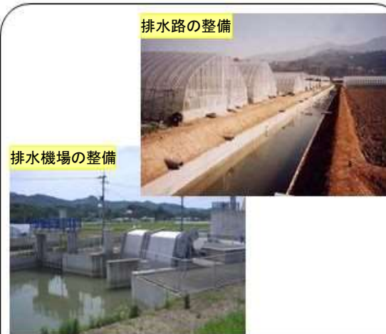
(事業実施) 排水機場、排水路の整備により、湛水被害の防止や地下水位の低下を図る。
