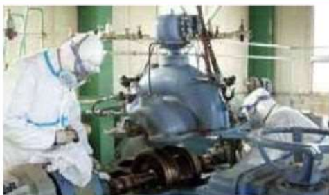
石綿が使用された機場における維持管理作業
