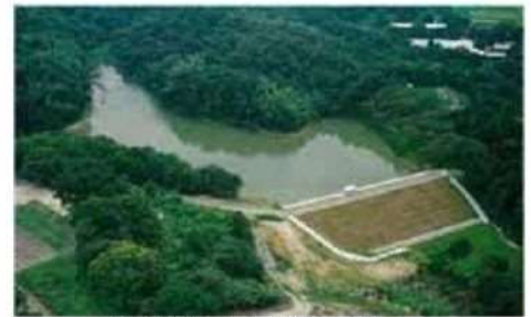
整備されたため池の全景
