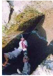
水路のひび割れ補修
