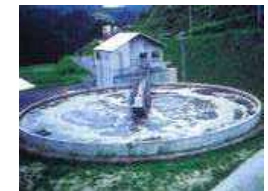
畜産環境対策施設
