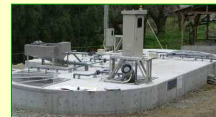
整備された浄化槽
