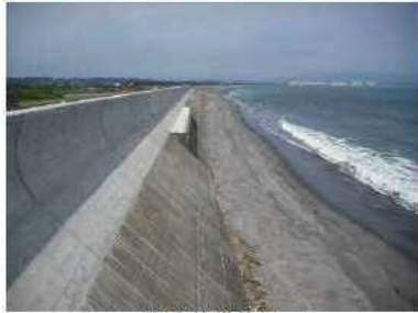
堤防整備状況
