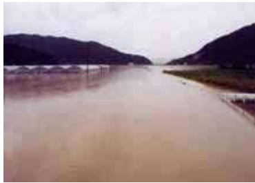
溢水した排水路
