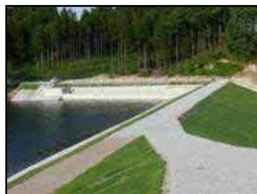
改修後のため池
