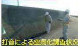
打音による空洞化調査状況
