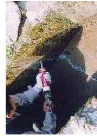
水路のひび割れ補修
