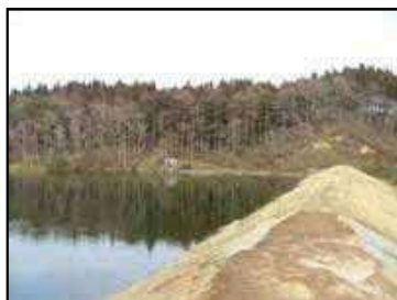
改修前のため池
