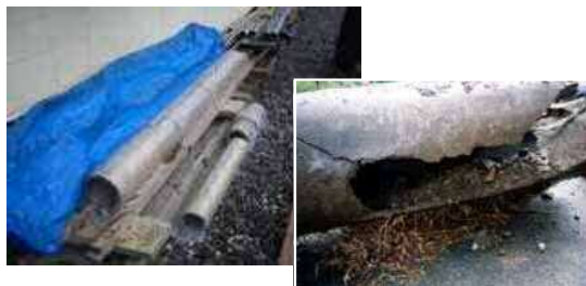
著しく老朽化し撤去された石綿セメント管
