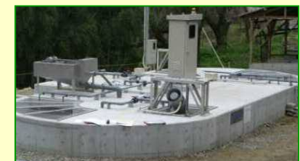
整備された浄化槽
